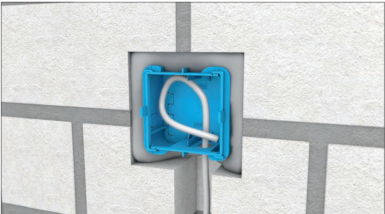
Bild 17: Die blaue Gerätedose wird eingesetzt und ausgerichtet.
