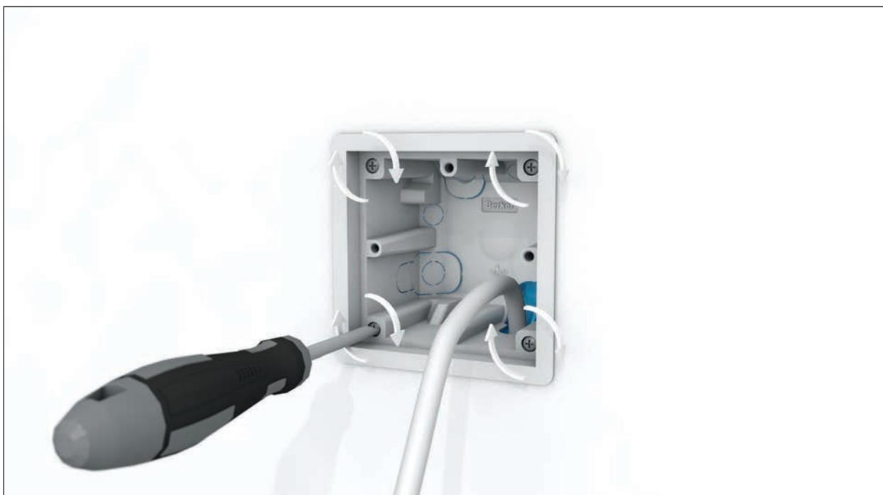
Bild 23: Die vier Schrauben mit den Krallen werden angezogen. Somit wird die hellgraue R.8 Hohlwanddose in der blauen R.8 Gerätedose befestigt.
