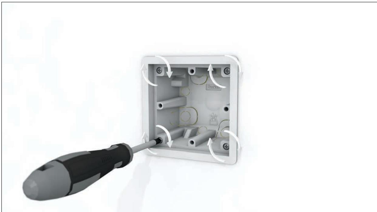
Bild 6: Die vier Schrauben mit den Krallen werden angezogen. Somit wird die hellgraue R.8 Hohlwanddose in der blauen R.8 Gerätedose befestigt.
