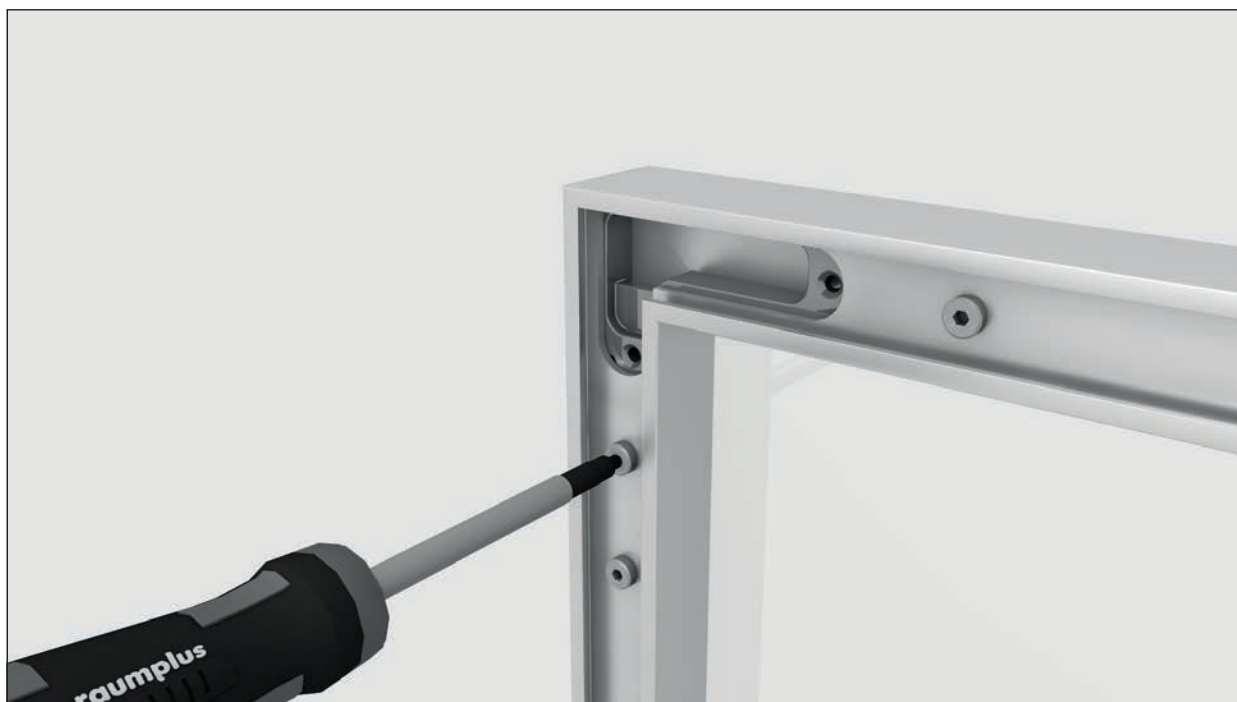
Bild 12: Die drei Schrauben vom Rahmenverbinder werden eingebracht und angezogen.
