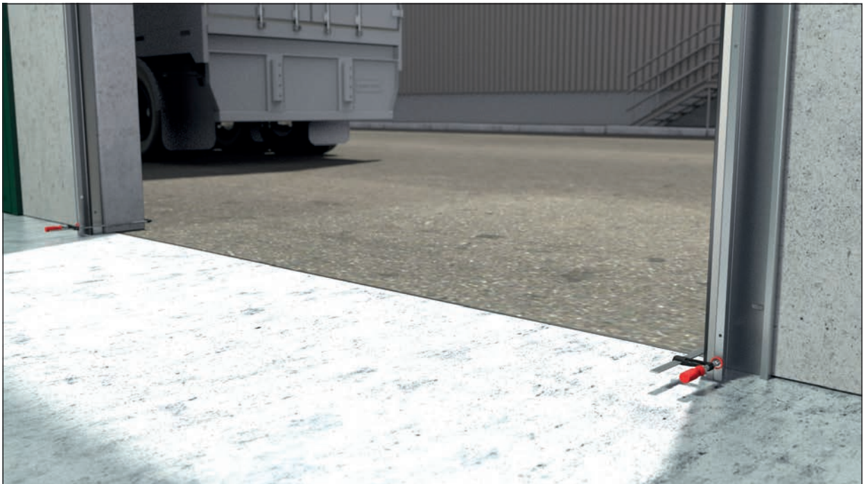
Bild 7 - Zargen werden unten mit je einer Schraubzwinde fixiert
