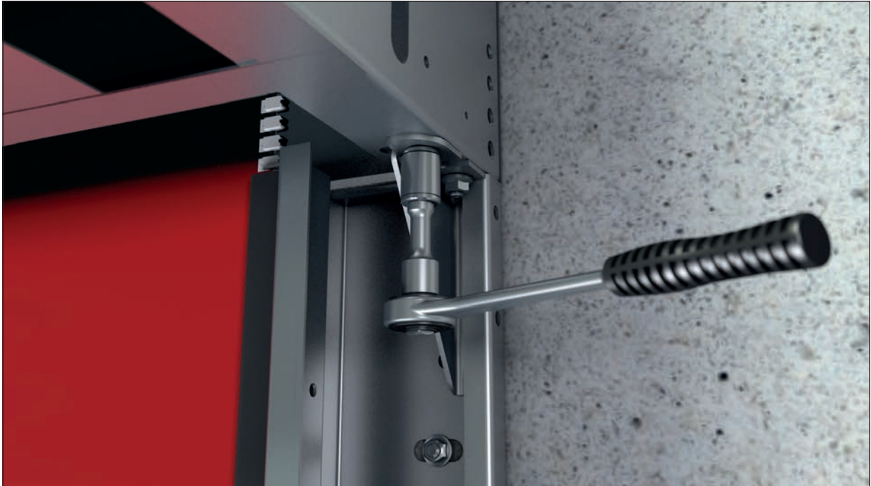
Bild 12 - Schrauben zwischen Wickelkasten und Zarge werden fest angezogen.
