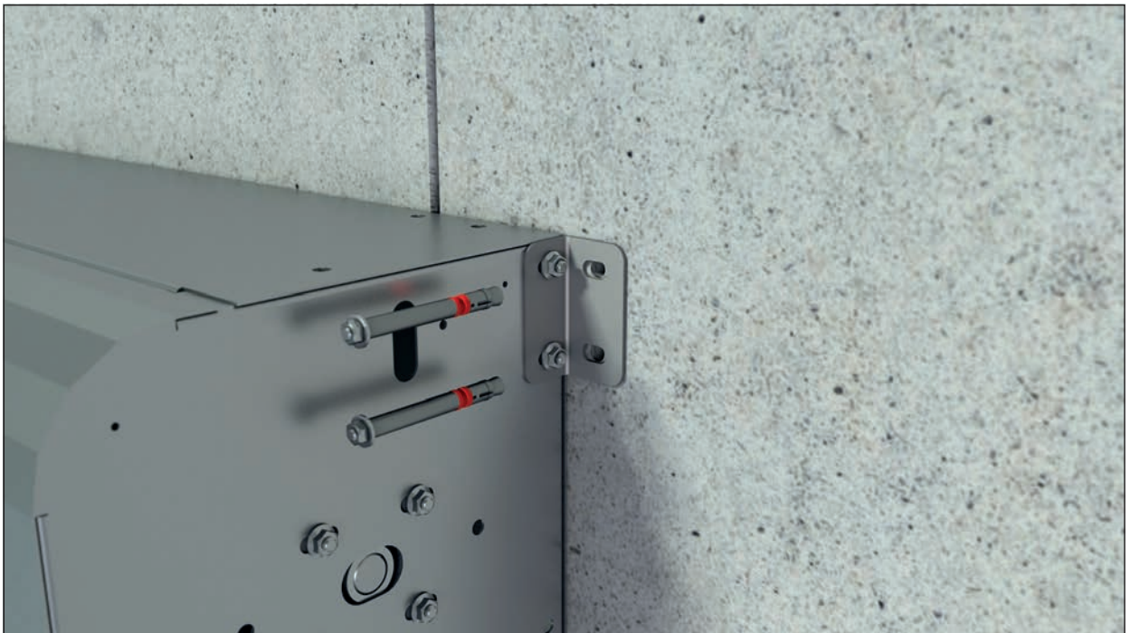
Bild 5 - Wickelkasten wird mit zwei Winkel rechts und links an Wand festgeschraubt
