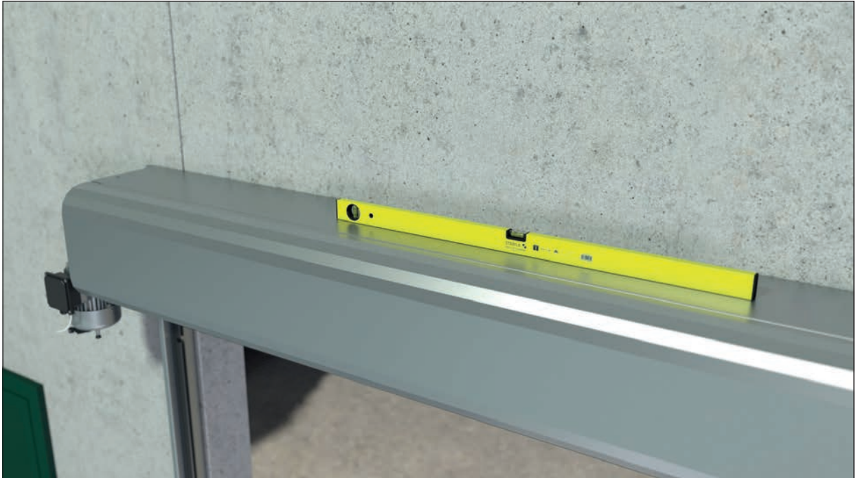
Bild 4 - Wickelkasten wird mit Wasserwaage ausrichten
