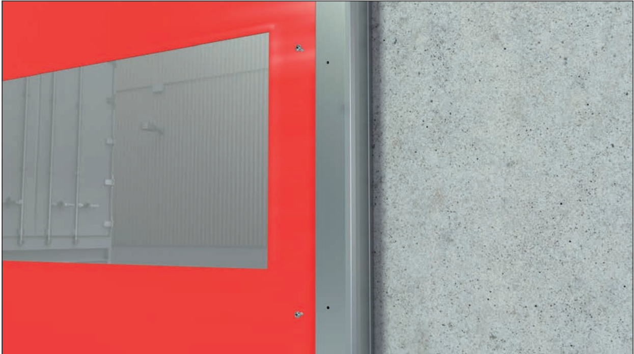
Bild 14 - Beide Zargendeckeln werden auf Zargenprofile aufsetzen und verschraubt
