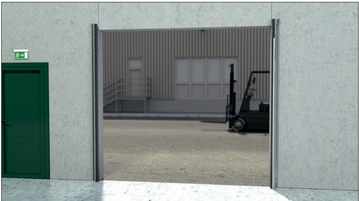
Bild 1 - Rechte und linke Zargen werden an Wand aufgestellt
