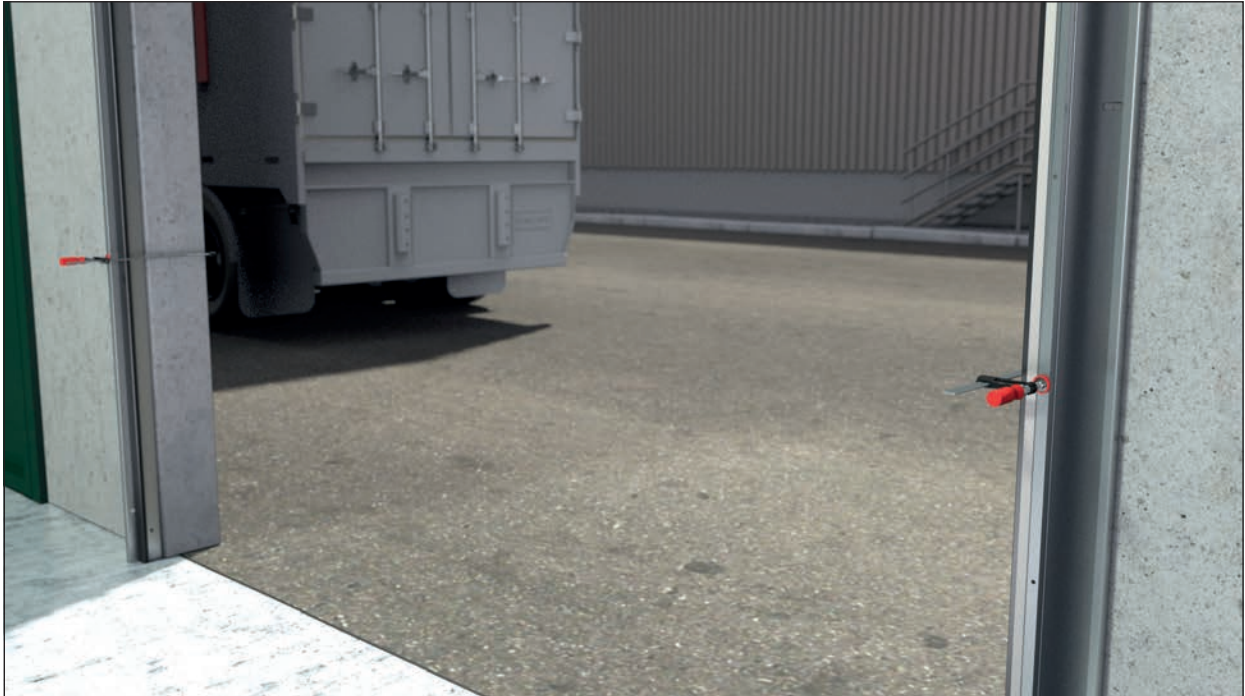
Bild 2 - Zargen werden jeweils mittig mit einer Schraubzwinde fixiert
