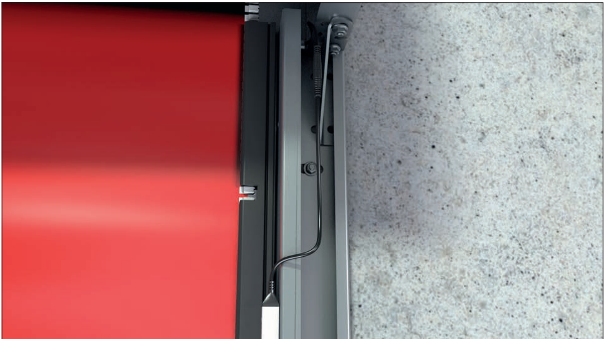
Bild 13 - Kabel Lichtgitter werden verbunden. Ein Kabel mit zwei schwarze Stecker wird einmal an Motorseite an Lichtgitter gesteckt, durch den Wickelkasten zur Gegenseite gelegt und mit dem 2. Lichtgitter zusammengesteckt.
