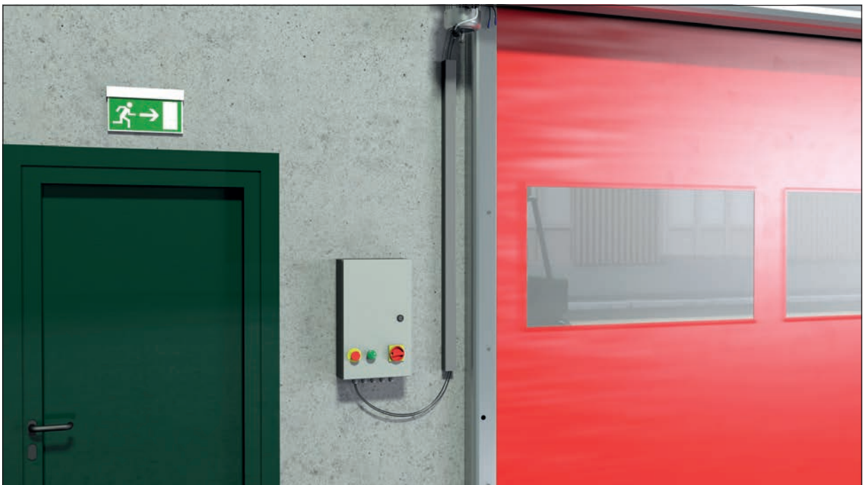
Bild 15 - Schaltschrank und Kabelkanal wird an Wand geschraubt
