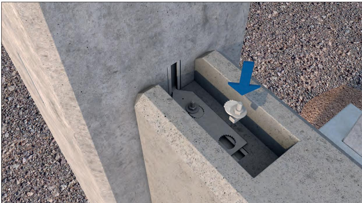
Bild 6: Vormontierte Hakenkopfschraube wird von oben durch die Lasche gesteckt und in der Ankerschiene um 90 Grad gedreht. Anschließend mit Schraubenschlüssel / Ratsche angezogen.
