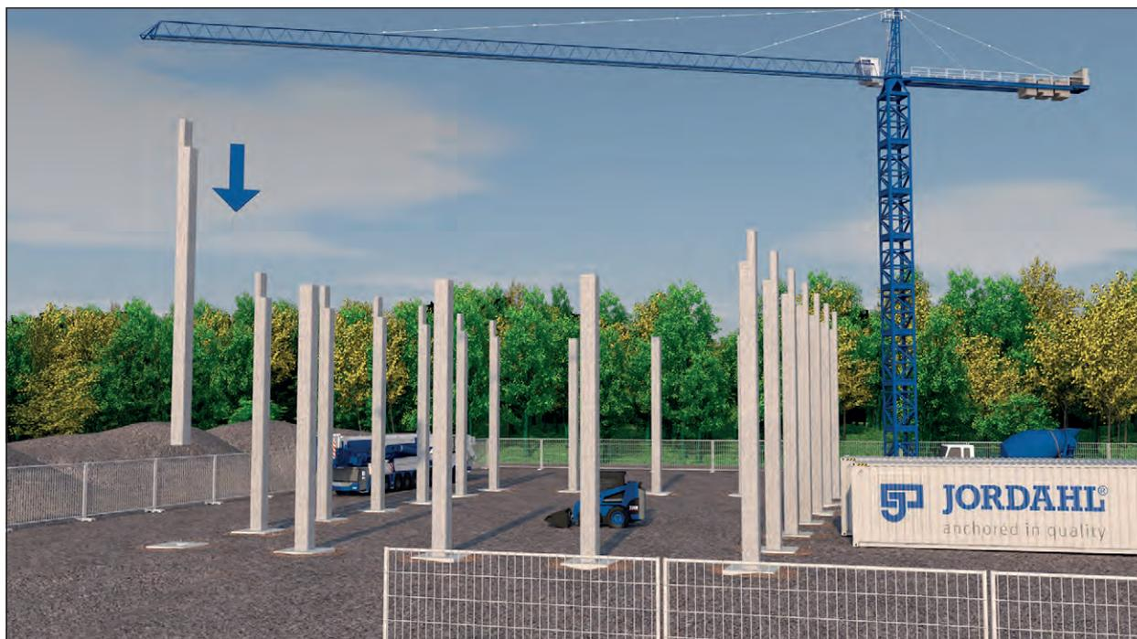
Bild 2: Betonstützen werden von oben in die Fundamente eingebracht. Im Video können diese nacheinander von oben ins Fundament „fliegen“.
